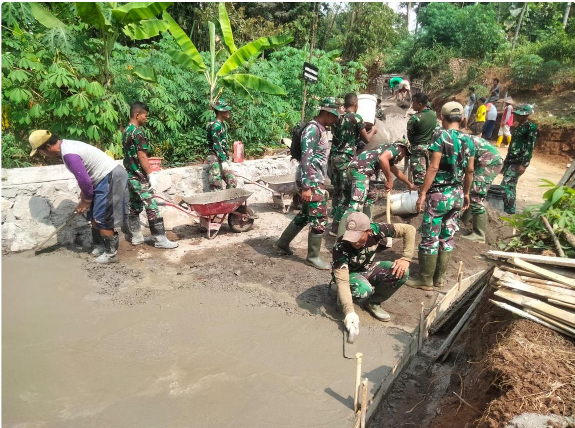
Tangan terampil para prajurit ini tidak perlu diragukan lagi. Semua mahir saling mengisi satu sama lain. Pantauan di lokasi Kamis, (16/5/2024) pagi. Salah satu bukti kemahiran mereka dalam satu setengah jam progres cor rabat beton bisa dicapai sepanjang 10 meter. Dengan alat mesin pengaduk semen digunakan 1 unit.
